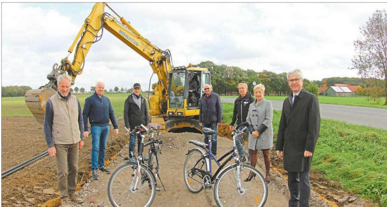
Ortstermin auf Abstand: Gemeinsam mit den Verantwortlichen des Radwegvereins machten sich Michael Vorderbrüggen und Annegret Bockey von der Volksbank (v. r.) ein Bild von den Arbeiten. Foto: D. Jeschke
