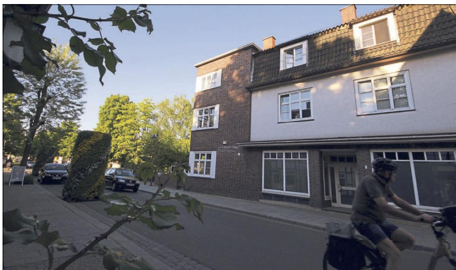
Zankapfel: Die Eigentümer Benjamin und Augin Sari planen den Abriss und Neubau des Gebäudes Rathausstraße 1 in Rietberg. Architekt Olaf Peterschröder hält das für einen Fehler. Er argumentiert für eine Unterschutzstellung der Immobilie als Baudenkmal.
